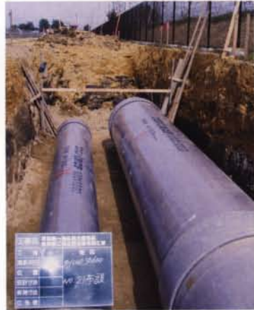
県営徳田第一地区用水管移設 (φ1000) 県営徳田第二地区用水管布設 (φ600) 工事施行状況
