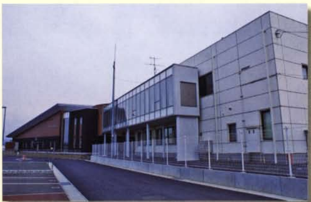
用水管理センターとの接続廊下
