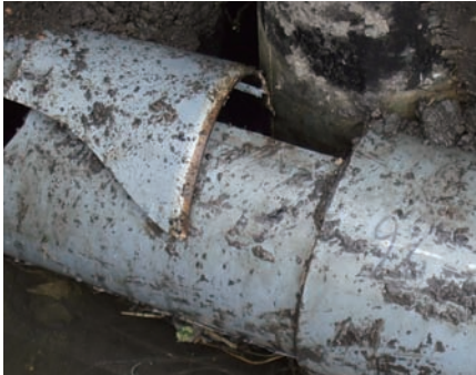
地震により破損したパイプライン
