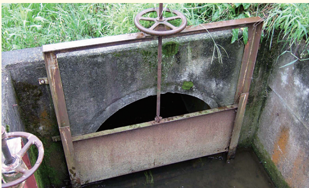
ゲート劣化状況
