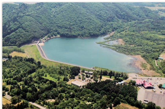
改修される煙山ダム
