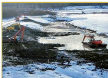
煙山ダムの堆砂除去作業状況
