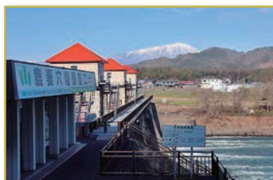
3回目の国営事業により現在改修中の 鹿妻穴堰頭首工
