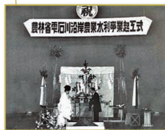
管内初の国営事業の起工式典の様子
