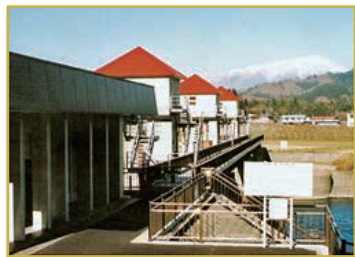
改修された鹿妻穴堰頭首工
