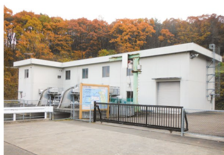
西部揚水機場
