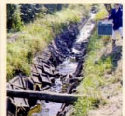
老朽化し、工が必要な 鹿妻新堰のようす
