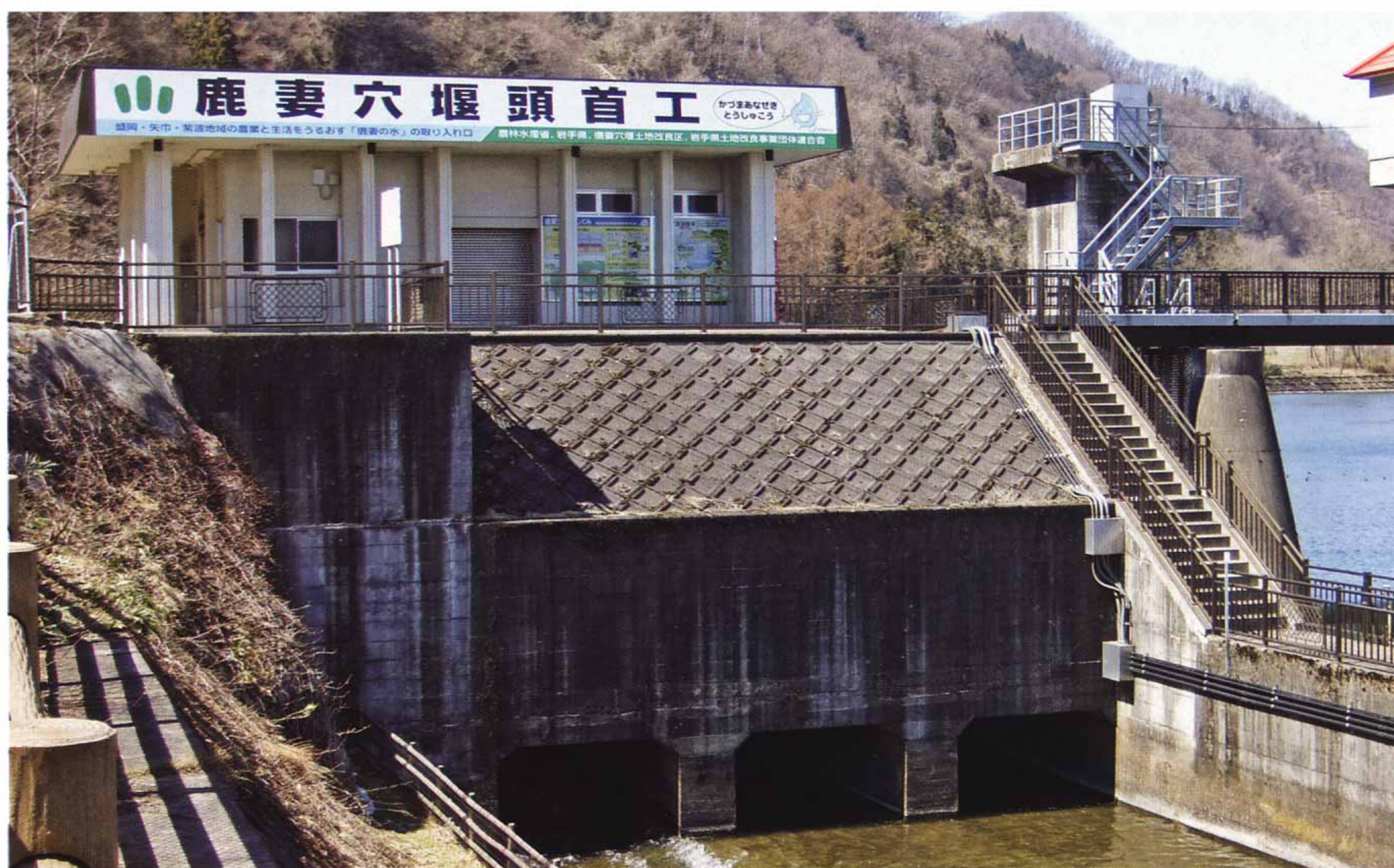
春の本格通水を待つ鹿妻穴堰頭首工取水口
