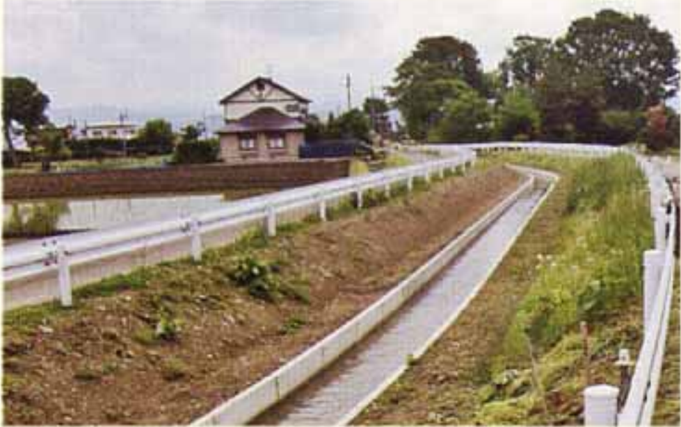
鹿妻新堰地区 H23年度完成区間 (盛岡市上太田中関地内)
