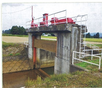
第5号堰上ゲート全景
