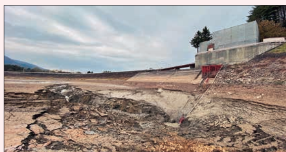
ダム湖内の堆砂状況
