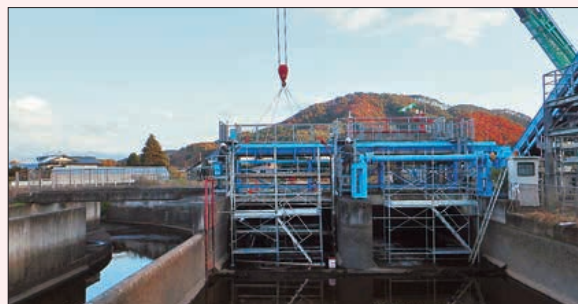
稲荷場大分水工除塵機分解の様子
