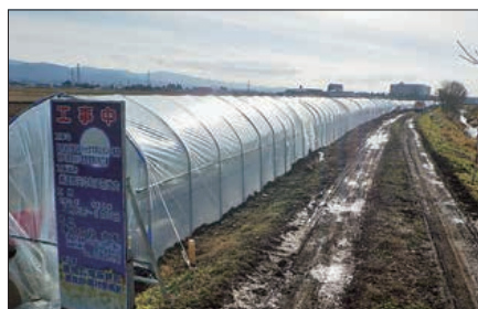
シートによる仮囲いをし施工中の 小鹿妻堰
