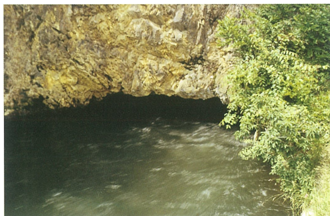
旧鹿妻穴堰頭首工取水口
