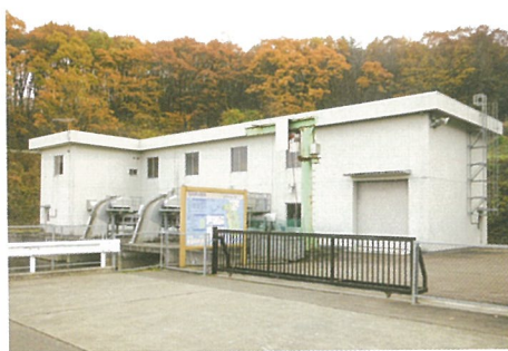
西部揚水機場
